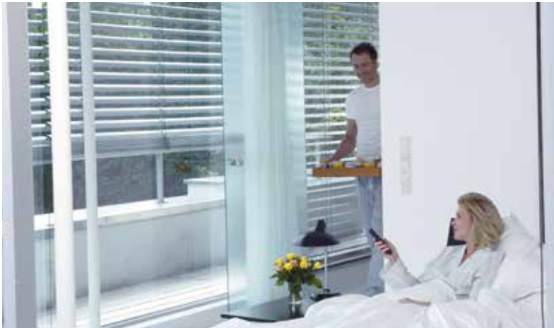
Bild 14: Sonnenschutz mit Rollladensteuerung
