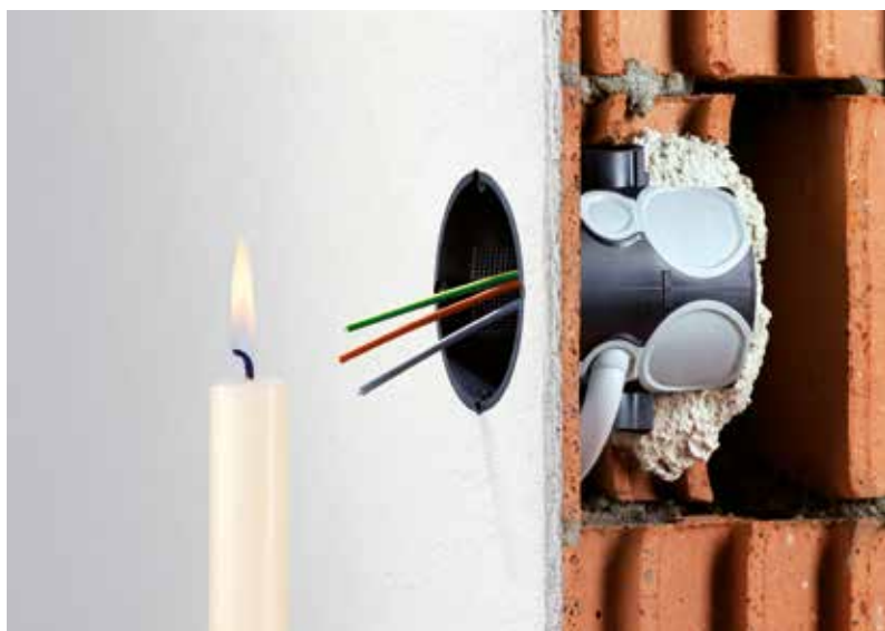
Bild 10: Luftdichter Einbau einer Steckdose in der Luftdichtheitsschicht (Innenputz)
