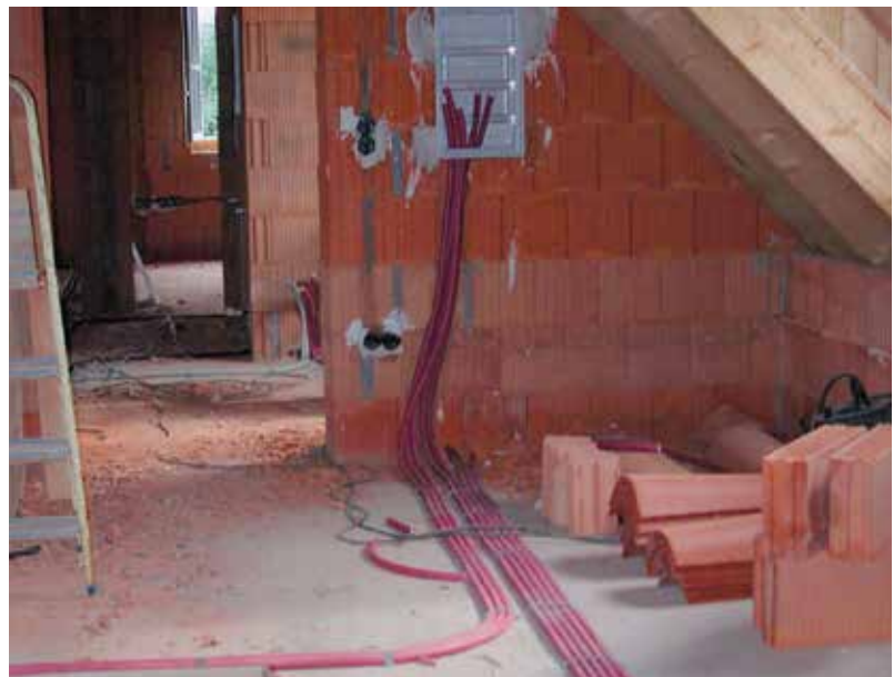
Bild 9: Verlegung von Elektroinstallationsrohren
