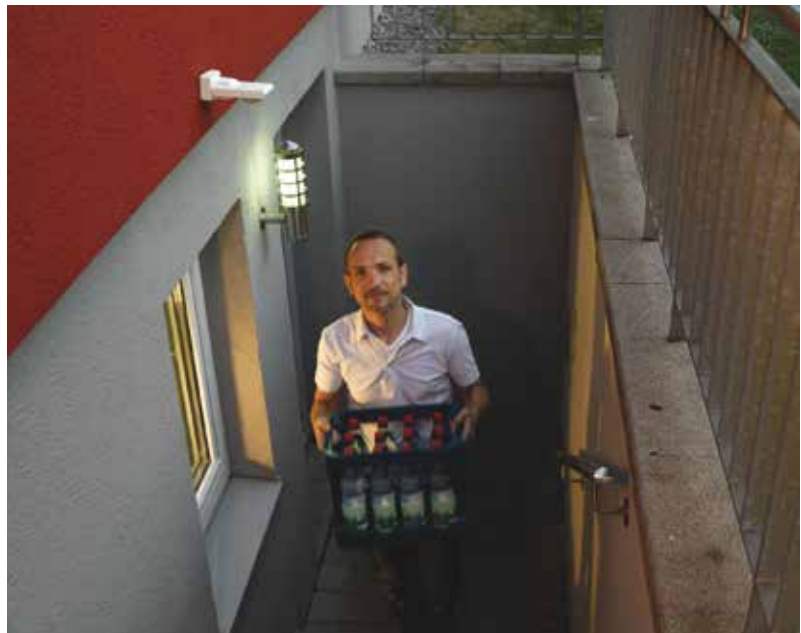
Bild 11: Energieeffiziente Beleuchtungsanlage, geschaltet durch Bewegungsmelder
